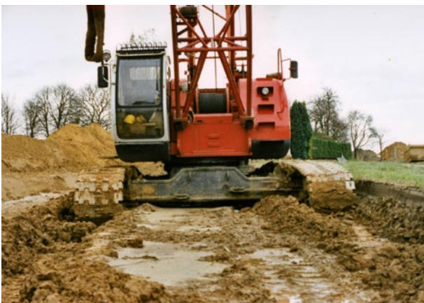
Abb 2: Befahrungen feuchter/nasser Böden bewirken Verdichtungen und Gefügeschäden (© Ingenieurbüro Feldwisch)
