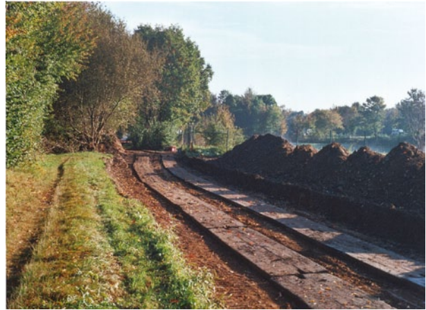
Abb 6a: Zum Schutz des Bodengefüges wurden auf einer Baustelle Holzbohlen längs in den Fahrspuren ausgelegt. Das Foto zeigt den Bodenzustand unmittelbar nach dem Auslegen der Holzbohlen. (© Ingenieurbüro Feldwisch)
