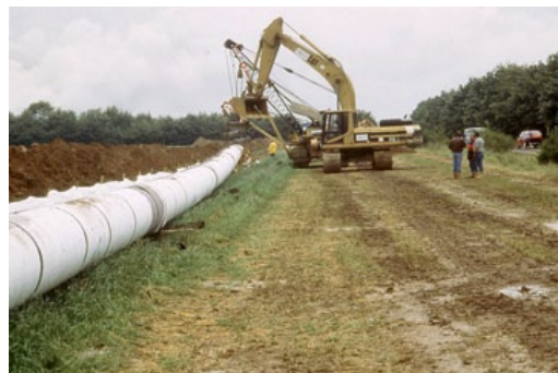
Abb 9: Begrünung der Fahrtrassen zur biologischen Entwässerung – Beispiel aus dem Rohrleitungsbau (© Dr. Gerhard Dumbeck)
