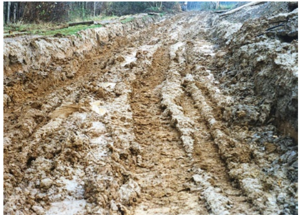
Abb 6b: Das Foto zeigt den Bodenzustand während der Bauphase. Die Bohlen sind während der Bauphase verrückt und in den Boden eingepresst worden, so dass der Boden nicht vor den schweren Lastenträgern geschützt wurde. Der Boden war vollständig verpresst und verdichtet, so dass aufwändige Tieflockerungsmaßnahmen durchzuführen waren. Bei einer Kontrolle der bodenschutzbezogenen Anforderungen durch die Bodenschutzbehörde oder eine bodenkundliche Baubegleitung wäre ein derartiger Ausführungsfehler aufgefallen. (© Ingenieurbüro Feldwisch)
