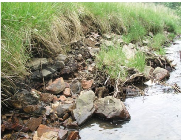
Abb 4: Ufererosion in einem durch historischen Erzbergbau stofflich belasteten Auenabschnitt (Abraum) (© Ingenieurbüro Feldwisch)
