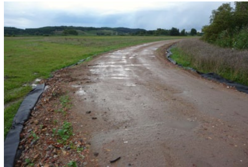
Abb 7: Mineralische Baustraße mit Geotextil als Unterlage (© Ingenieurbüro Feldwisch)
