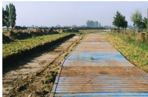
Abb 8: Baustraße aus Stahlmatten (© Ingenieurbüro Feldwisch)
