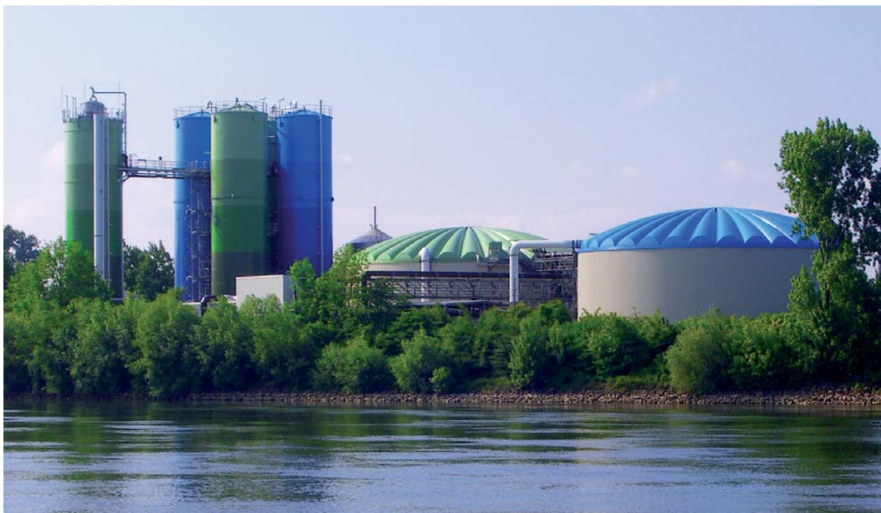
Abb. 17 Abwasserbehandlung industrieller Abwässer mit aerober und anaerober Reinigungsstufe (Quelle: InfraServ GmbH & Co. Wiesbaden KG)
