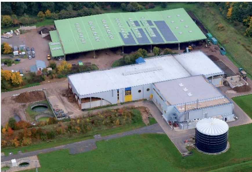
Abb. 4 Kombinierte Bioabfallbehandlung mit Vergärungs- und Kompostierungsanlage, WEAG, Friedberg (Quelle: www.mm-fotowerbung.de)
