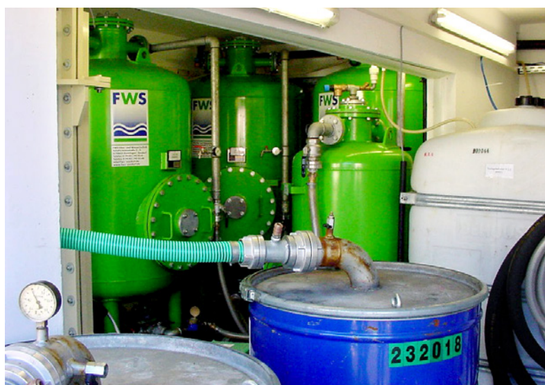
Abb. 2: Anlagentechnik in Doppelgarage.
