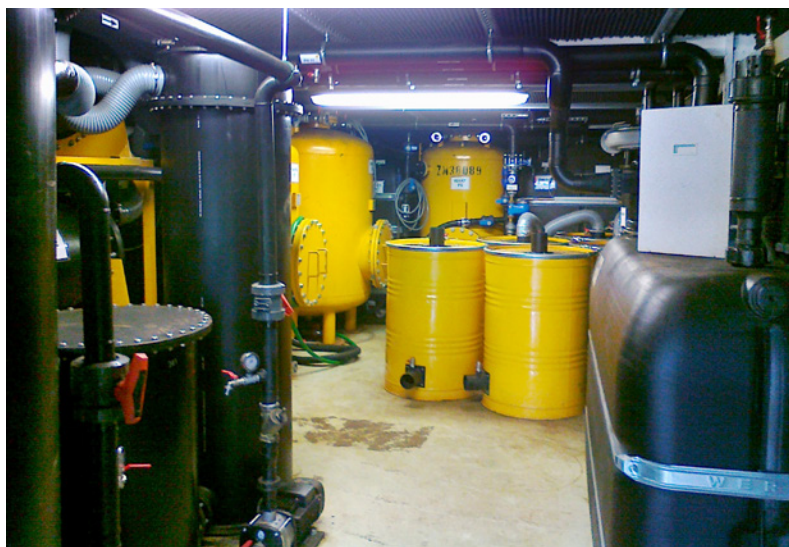
Abb. 4: Anlage mit Horizontal- und Turmstrippern.
