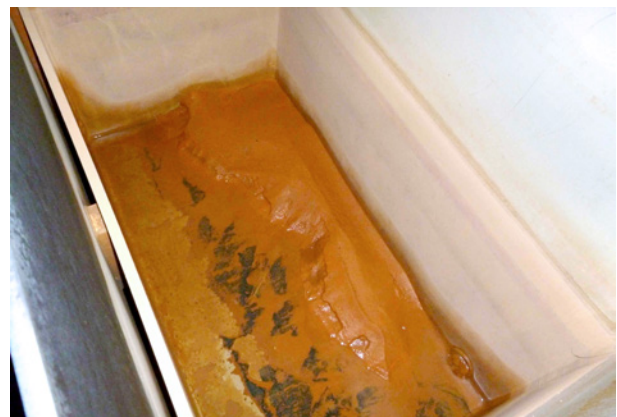
Abb. 6: Eisenschlamm und Feinsediment im Horizontalstripper H1.
