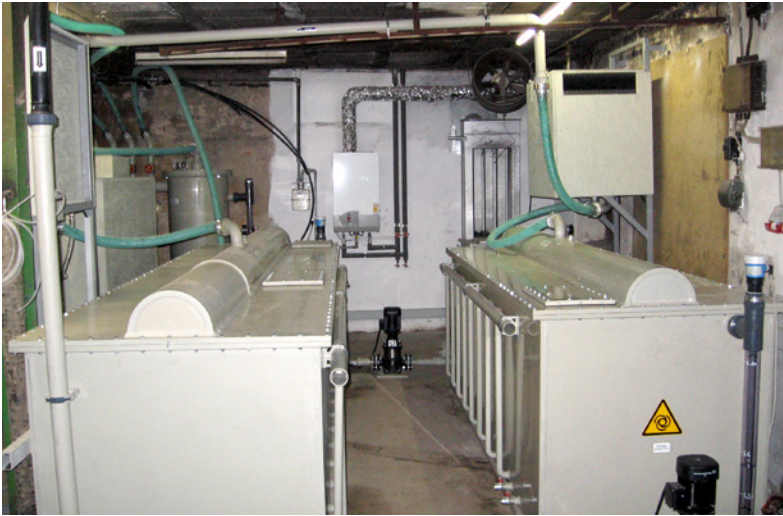
Abb. 5: Horizontalstripper H1 und H2.
