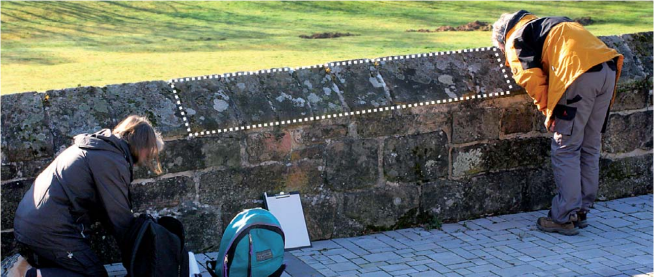
Abb. 68: Untersuchung eines Mauerabschnittes.
