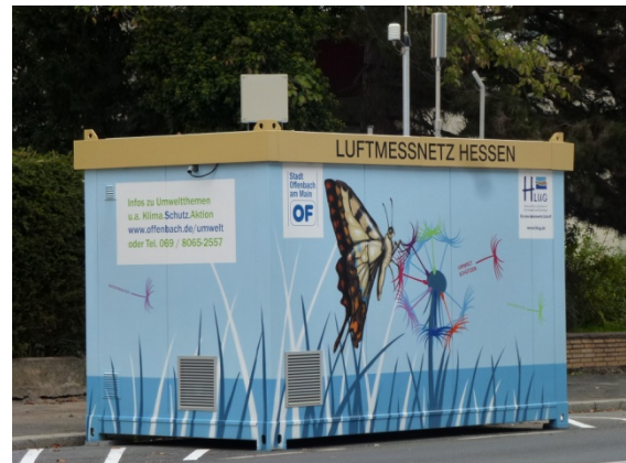
Abbildung 3: Luftmessstation Offenbach-Untere Grenzstraße
