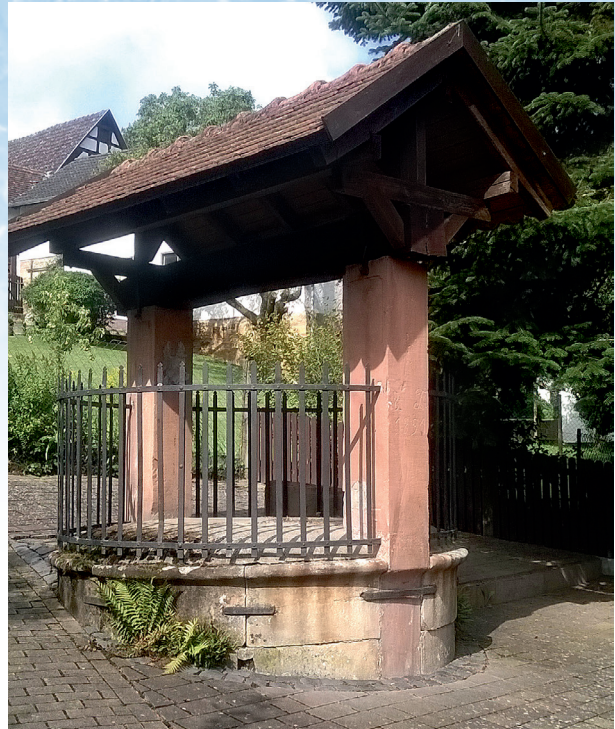
Abb. 2: Schachtbrunnen Wippenbach Nr. 486039.
