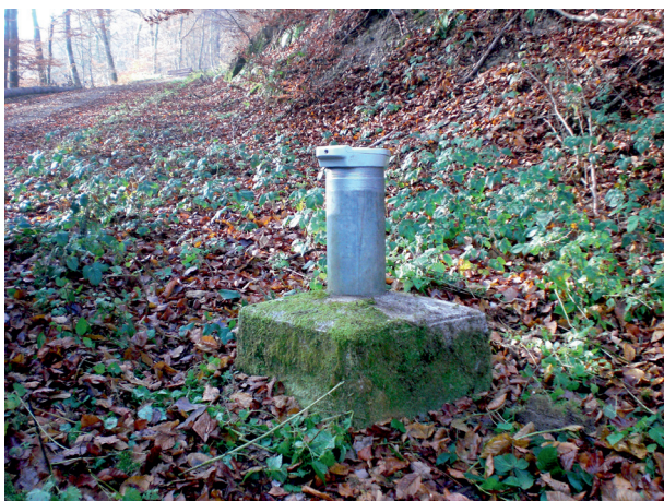
Abb. 1: Grundwassermessstelle Wörsdorf Nr. 506029.
