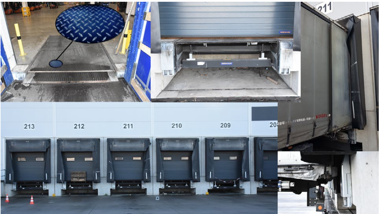
Abb. 25: Detailaufnahmen der untersuchten Laderampen
