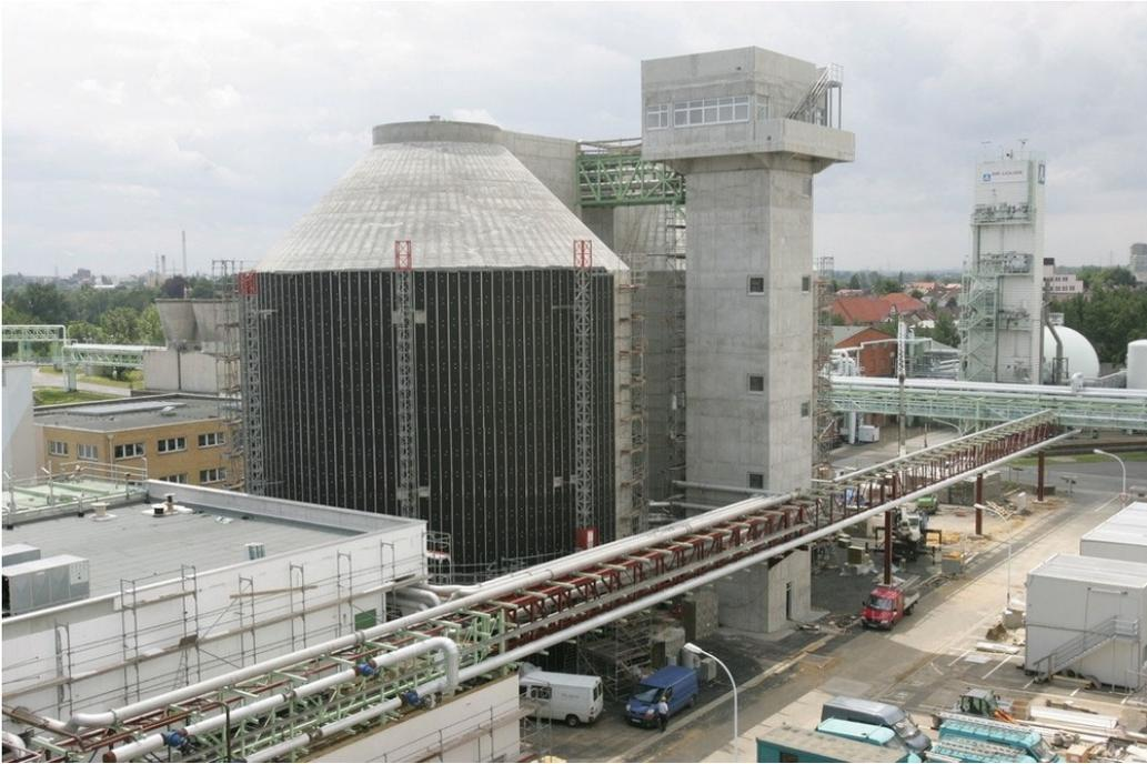
Abb. 37: Biogasanlage (2 x 10.800 m<sup>3</sup>) zur Vergärung von Klärschlamm und Reststoffen im Industriepark Höchst
