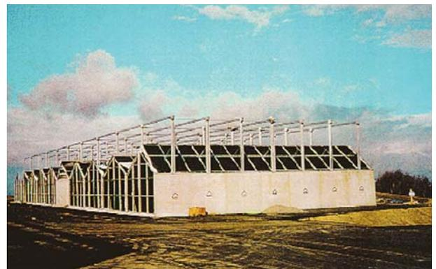
**Abb. 5.** Rottemodule mit einer automatischen Klappabdeckung.
