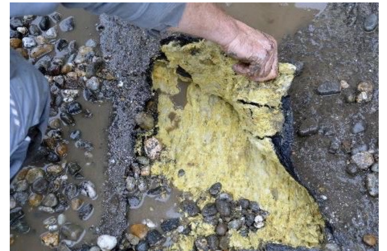
Bitumendeckung auf Mineralwolle, verklebt
