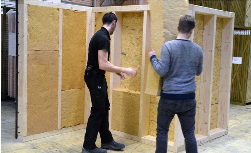
Holzprofilfassade vor Holzständerwand mit Holzweichfaserdämmung
