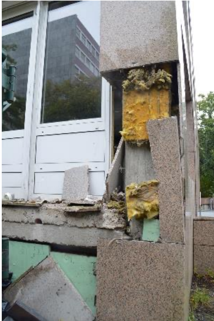
Natursteinfassade mit Mineralwolldämmung und EPS im Sockelbereich
