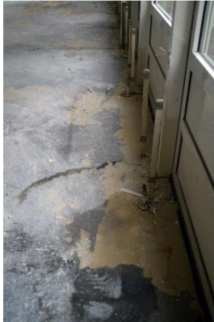
Hohlraumboden mit Resten des Teppichbodens
