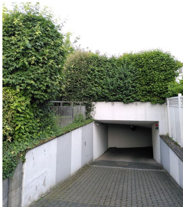
Abb. 2: Verwendung versickerungsfähiger Beläge (links), Überdeckung baulicher Anlagen im Boden (rechts) © HLNUG
