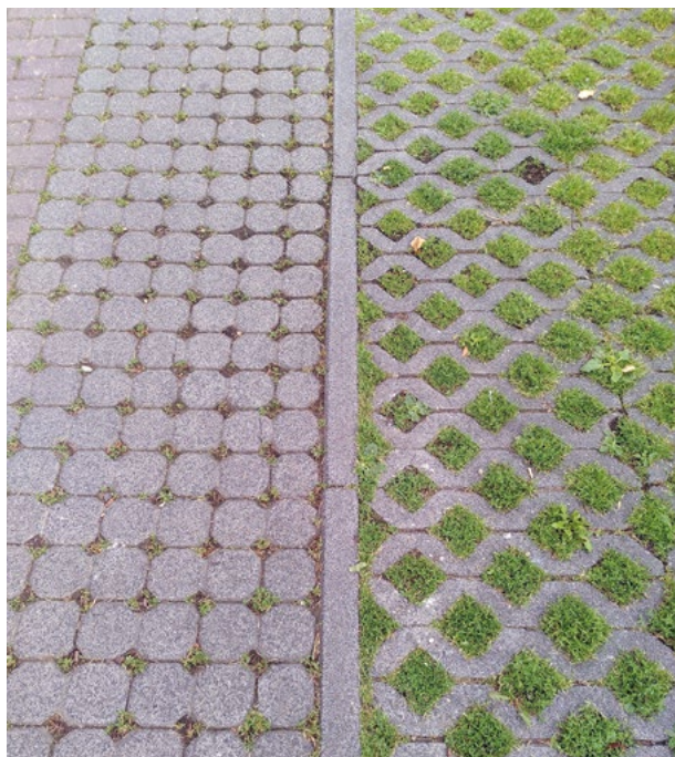
Abb. 2: Verwendung versickerungsfähiger Beläge (links), Überdeckung baulicher Anlagen im Boden (rechts) © HLNUG
