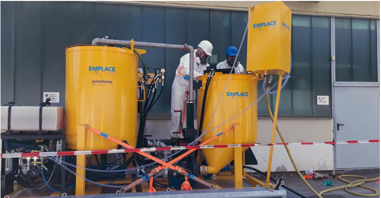
Abb. 4: Durchführung der Injektionen (Sanierung im technischen Maßstab)
