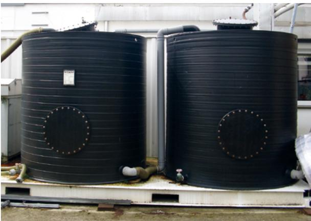
Abb. 6: Fallbeispiel 4 – Zwei 4 m<sup>3</sup> große Luftaktivkohlefilter im Freien
