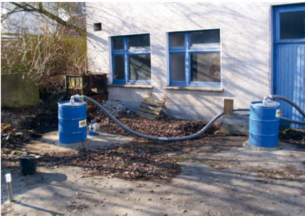
Abb. 4: Fallbeispiel 3 – ProAir-Absaugsysteme im Außenbereich
