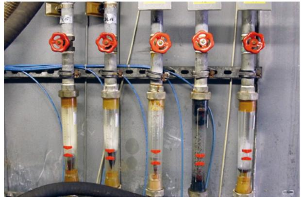
**Abb. 8:** Fallbeispiel 4 – Schwebedurchflussmesser mit Wasser und ausgeschwemmter Aktivkohle
