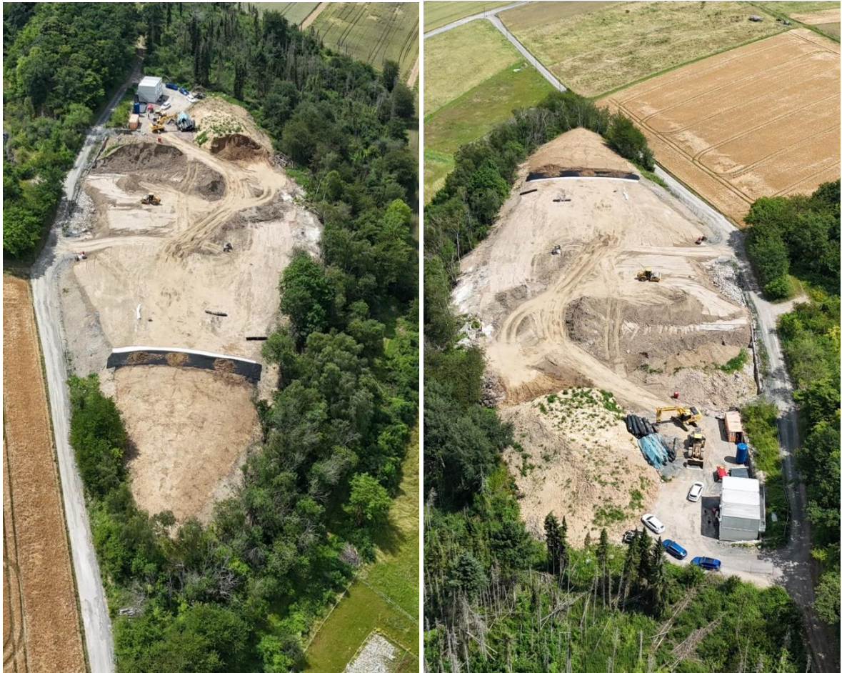
Abb. 4 u. 5: Bau des Abdichtungssystems aus Drainagematte (schwarz) und Tondichtungsbahn (weiß) in Blickrichtung West (links) und Ost (rechts) im Sommer 2024 (Quelle: D. Fröhlich, HIM-ASG).
