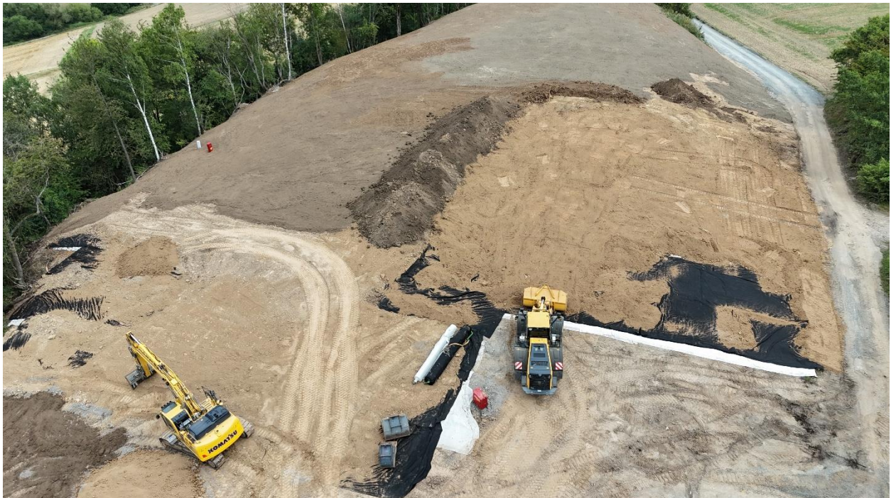
Abb. 6: Detailaufnahme des Aufbaus des Abdichtungssystems (Quelle: D. Fröhlich, HIM-ASG)
