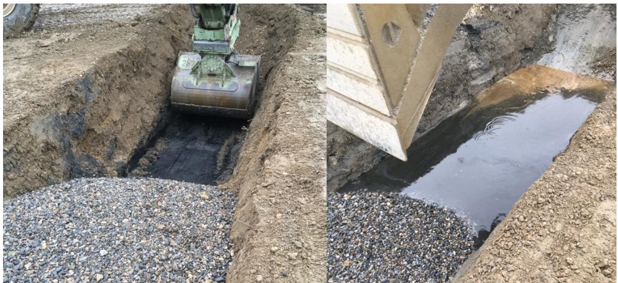
Abbildung 1: Einbringen von durchlässigem Kies zur Schaffung von Wegbarkeiten in die ungesättigte Zone.
