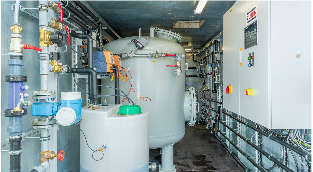
Abbildung 4: Anlagentechnik zur Vorbehandlung des Injektionswassers mit großem Bioreaktor zur Sauerstoffzehrung.
