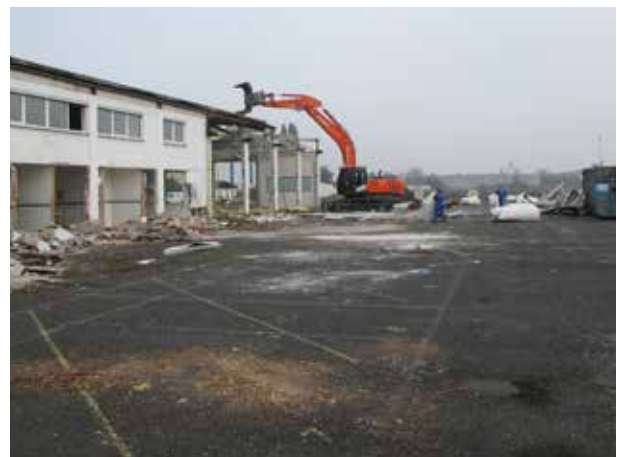
Abb. 6: Rückbau der Werkstatthalle.
