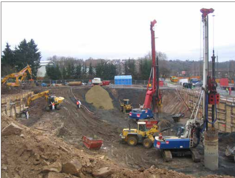
Abb. 5: Bodensanierung mit Austauschbohrungen (D = 2 m).
