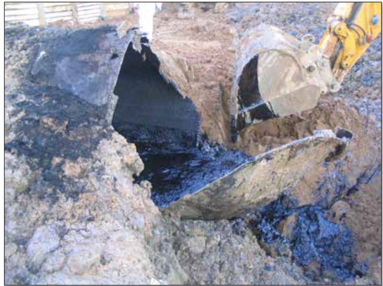
Abb. 6: Abbruch der Teergruben/Teerölkonditionierung.
