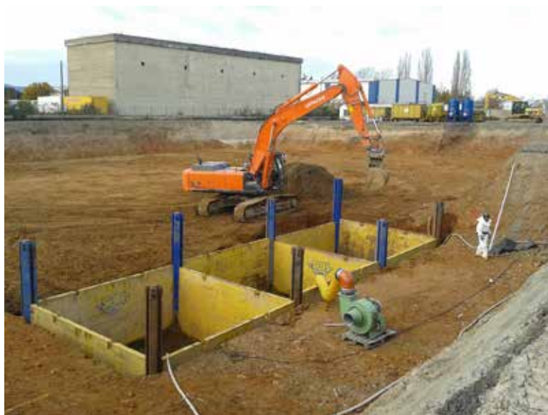
Abb. 8: Nassaushub im Gleitschienenverbau.
