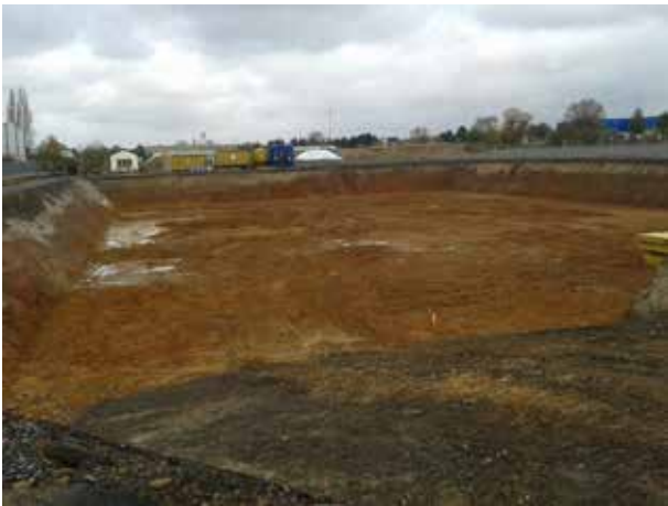
Abb. 7: Trockener Voraushub.
