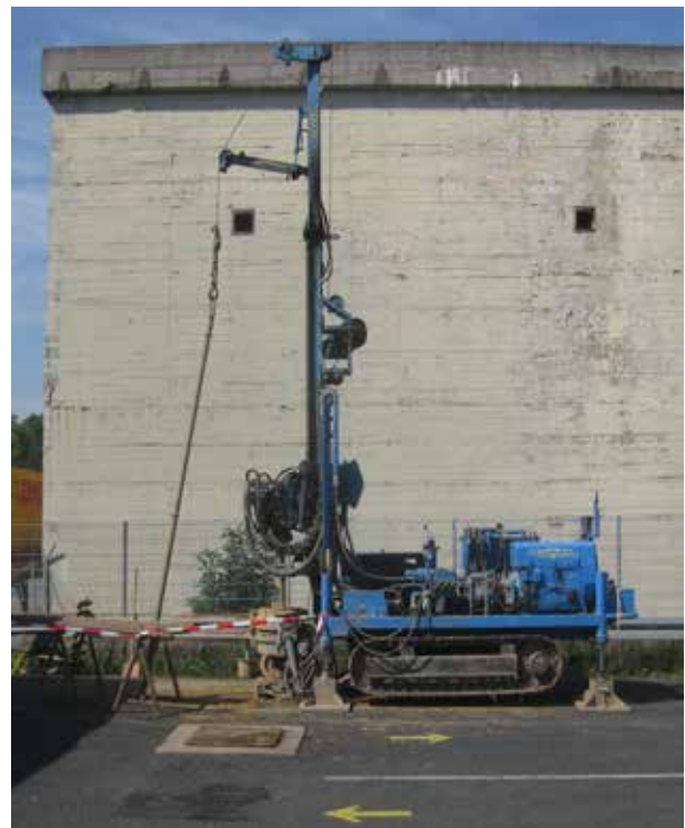
Abb. 2: Kernbohrung bei Erkundung.
