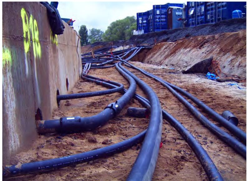
reichen begonnen. Die Sanierungsinfrastruktur bestand aus 64 Airsparging- und 35 Bodenluftabsaugbrunnen. Die laufende Sanierung unterlag vielfachen Optimierungs- bis hin zu ergänzenden Erkundungsmaßnahmen:
