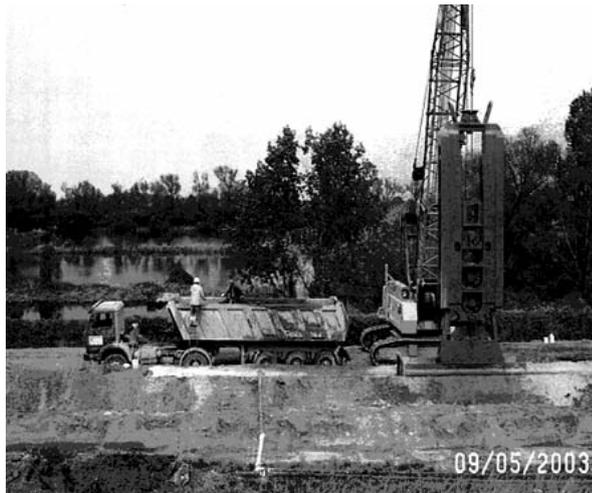
**Abb. 9:** Dichtwandherstellung mit Schlitzwandgreifer (Deponie Vorketzin).
