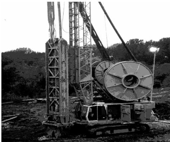
**Abb. 10:** Einsatz einer Schlitzwandfräse (Deponie Malsch).
