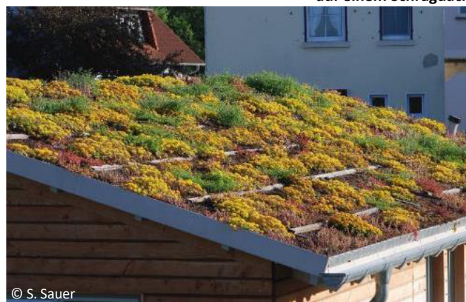
Extensive Dachbegrünung auf einem Schrägdach
