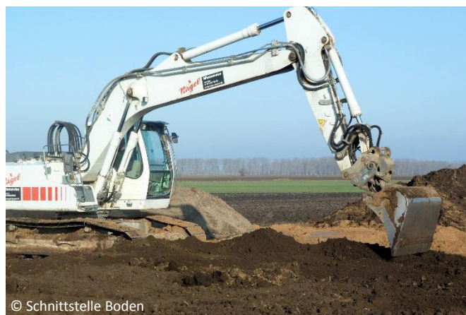
Wiedereinbau von Oberbodenmaterial
