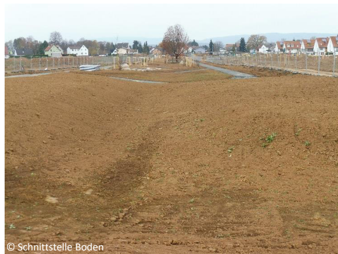
Mulden- und Rigolensystem in einem angelegten Grünzug eines Baugebietes
