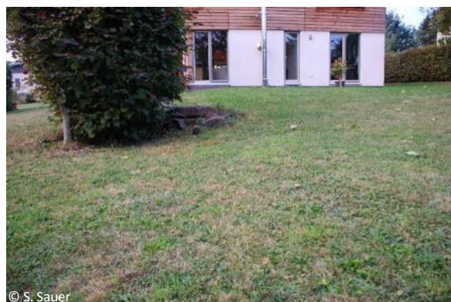
Versickerungsmulde auf privaten Grundstück
