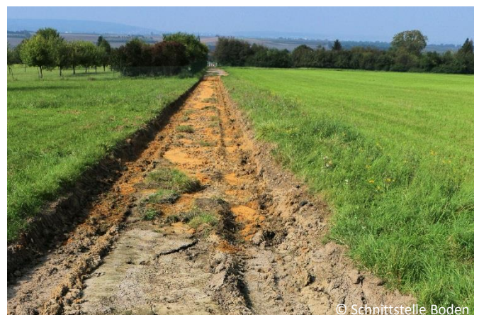
Entsigelter Wirtschaftsweg vor Herstellung einer durchwurzelbaren Bodenschicht
