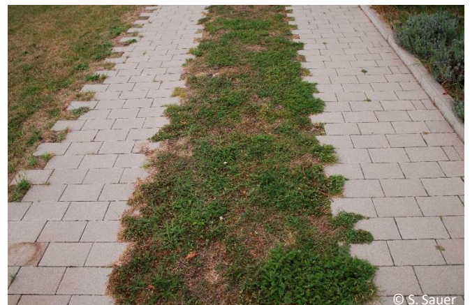
Teilschotterrassen – wasserdurchlässiger Belag mit höherer Wasserspeicherfunktion im Vergleich der Belagsarten
