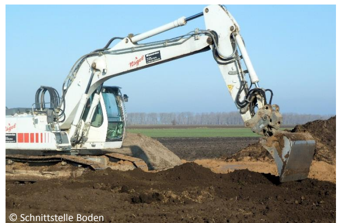
Wiedereinbau von Oberbodenmaterial
