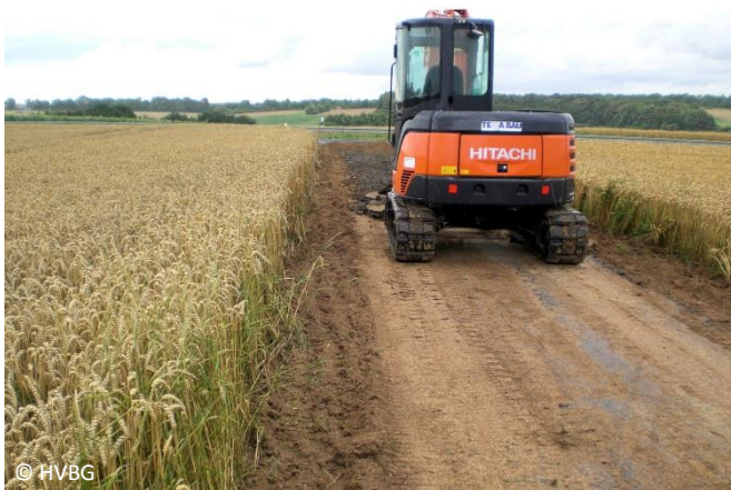
© HVBG Entsiegelung des Wirtschaftswegs mit vollständiger Entfernung des Unterbaus
