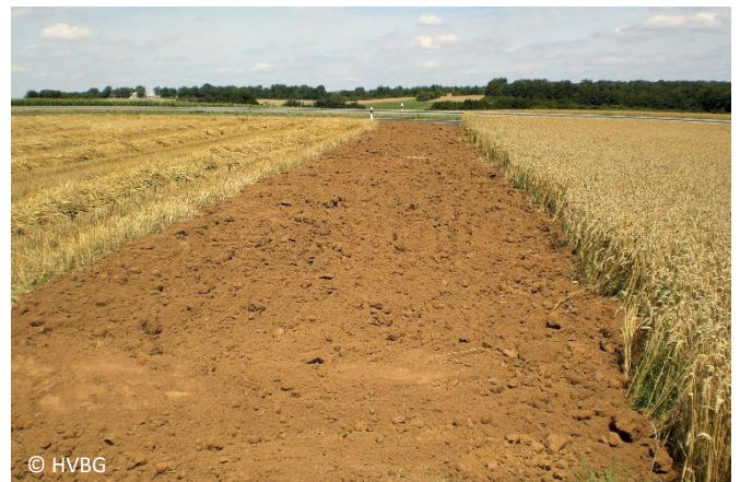
© HVBG Zustand nach Entsiegelung und Herstellung einer durchwurzelbaren Bodenschicht (vor der Ansaat)
