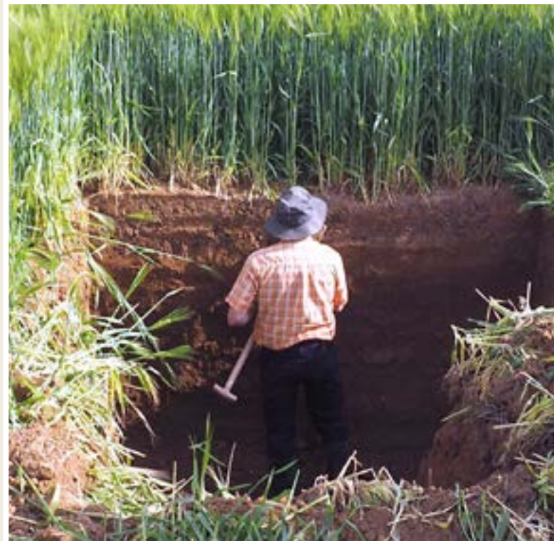
Begehbare Schurf zur Bodenerkundung (Lardenbach) © HLNUG
