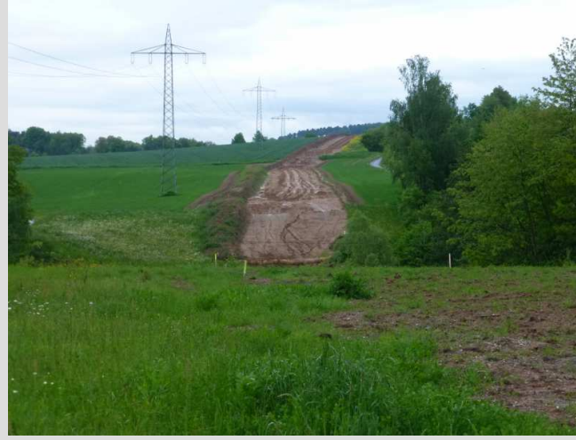
Bauphase Rohrleitung © Ingenieurbüro Feldwisch
