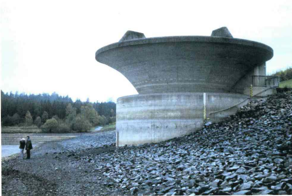
Abb. 1. Antrifftalsperre: Hochwasserentlastung und Dammfußbereich, links anschließend der entleerte Beckenbereich.
