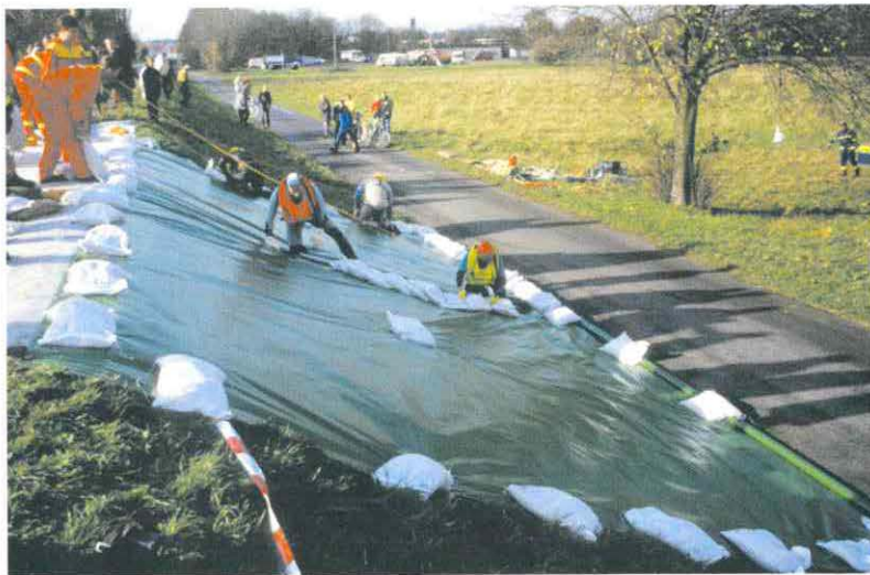
Abb. 4. Flächenhafte Abdichtung der wasserseitigen Böschung mit Kunststofffolien.
