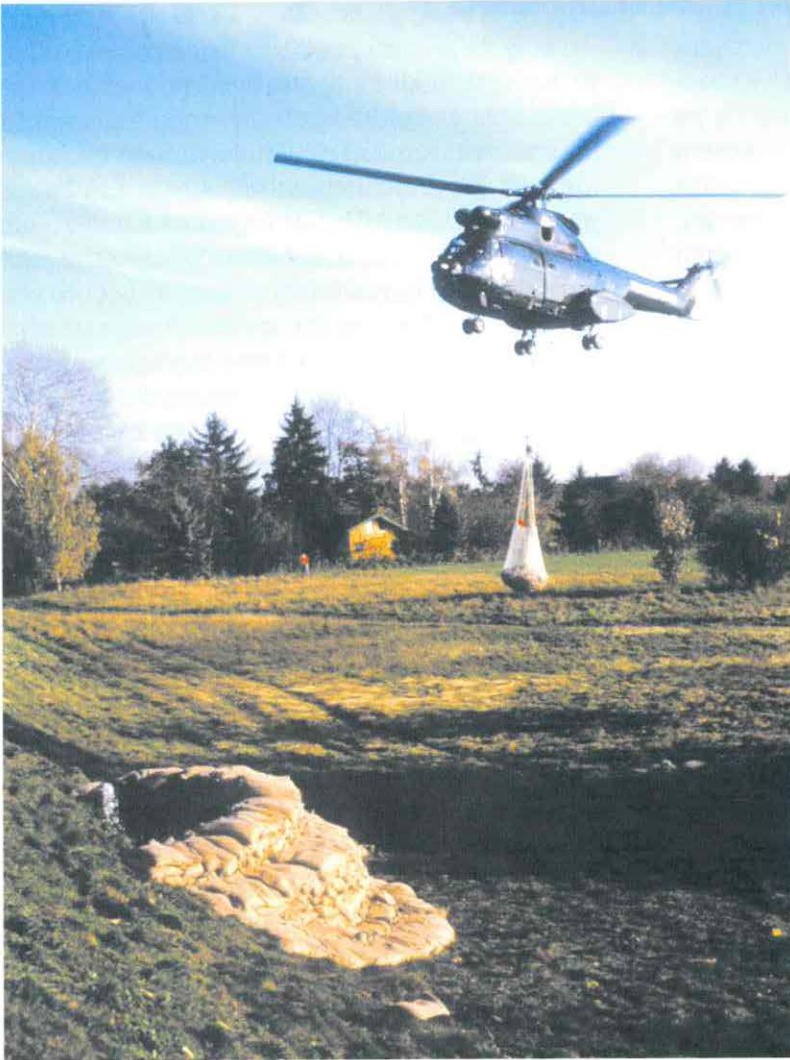
Abb. 3. Quellkade aus Sandsäcken zur Sicherung von Sickerwasseraustritten aus dem Deich.
