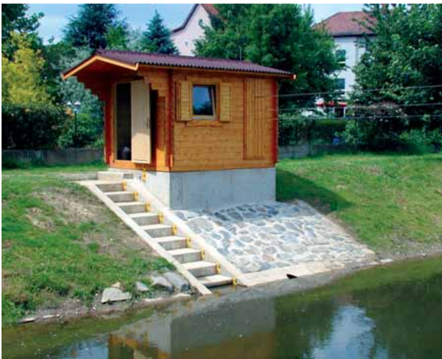
Abb. 2: Neubau des Pegels Friedberg an der Usa.
