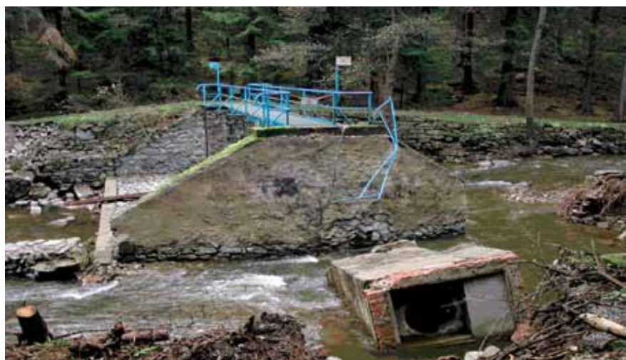
Abb. 1: Zerstörter Pegel Ammeldorf/Wilde Weißeritz im Osterzgebirge nach Ablauf der Hochwasserwelle im August 2002 (Quelle: Sächsisches Landesamt für Umwelt).
