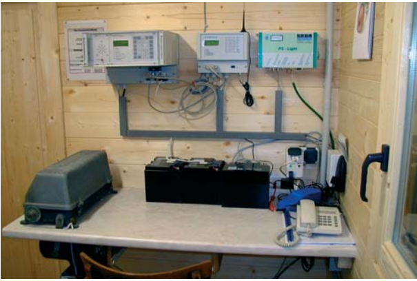
Abb. 13: Redundante Messtechnik zur Wasserstandserfassung, -registrierung und -übertragung (2002).
