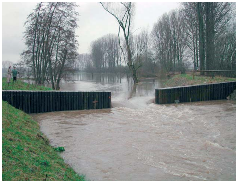
Abb. 9: Aktivierter Retentionsraum Groß-Zimmern an der Gersprenz (LK Darmstadt-Dieburg) Quelle: HARTMANN, RP Darmstadt.
