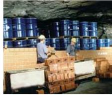
Nachdem eine Einlagerungskammer vollständig verfüllt wurde, wird sie eingemauert. Die Abmauerung als Teil des Barriersystems umschließt die eingelagerten Abfälle und trennt sie von den übrigen Grubenräumen ab.
