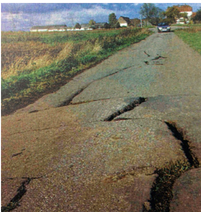
Abb. 8: Setzrisschäden an Gebäuden und Straßen (Quelle: Das Hessische Ried zwischen Vernässung und Trockenheit, HMULV, 2005).
