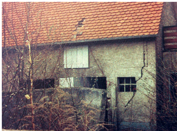
Abb. 8: Setzrisschäden an Gebäuden und Straßen (Quelle: Das Hessische Ried zwischen Vernässung und Trockenheit, HMULV, 2005).
