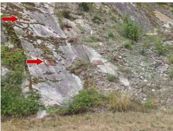
Abb. 7a: Hang an der L 3031 nach Espenschied: Das Einfallen der Trennflächengefüge entspricht etwa der Hangneigung. Nach aufgetretenen Rutschungen seit 1973 mit Ankern gesichert.
