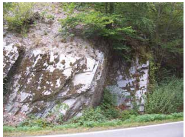
Abb. 7b: Aufschluss an der L 3033 durch das Wispental: Trennflächengefüge deutlich steiler als Hangneigung. Keine Sicherung nötig.
