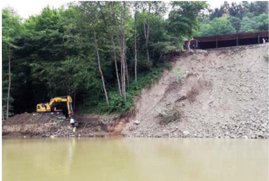
**Abb. 2:** Situation an der unterspülten, abrutschgefährdeten Böschung des ehemaligen Bahnhofsdamms in Antweiler © HLNUG
