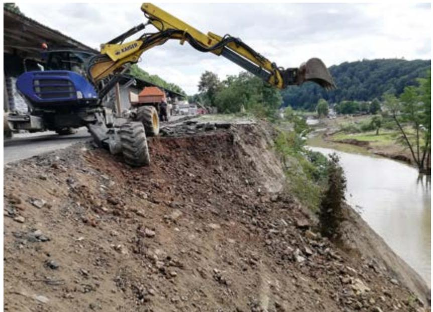
**Abb. 4:** Einsatz eines Schreitbaggers zum Brechen der übersteilten Böschungskante, Situation am 29.07.2021 © HLNUG
