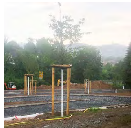
Abb. 4: Klimabaumpfad während der Bauphase 2021 © Hoeckner/HLNUG
