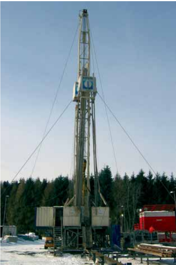
Abb. 3: Bohranlage zum Abteufen tiefer Bohrungen, z. B. Geothermiebohrungen.
