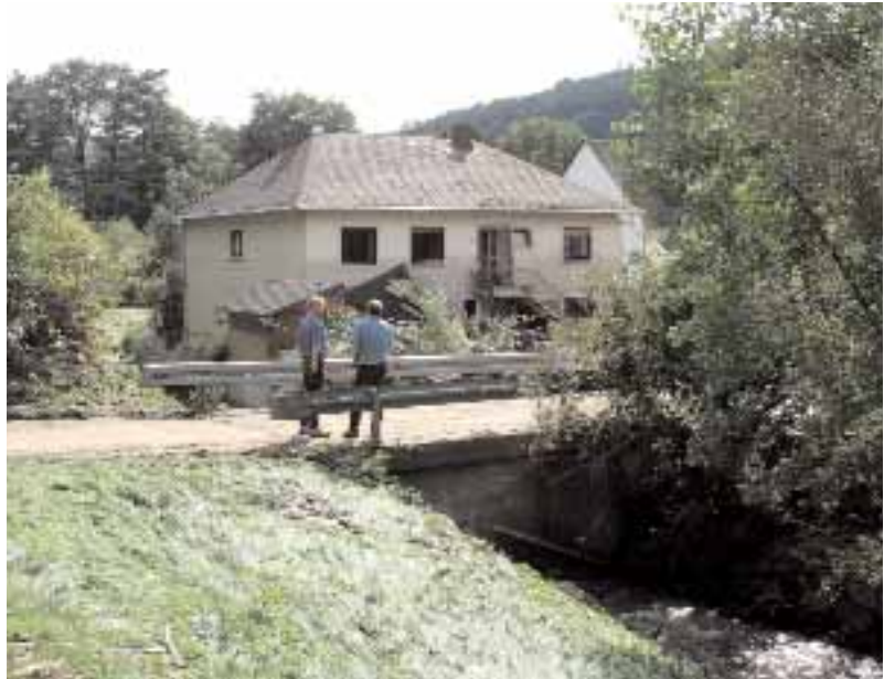
Abb. 7: Bis zur Fensterunterkante eingestautes Haus bei Sechshelden.
