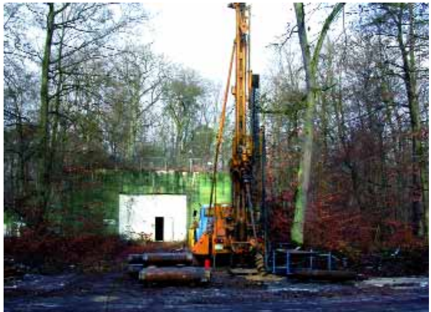
Abb. 2: Die Bohrstelle ca. 2 km nördlich von Viernheim im Hessischen Staatswald. Der befestigte Vorplatz eines stillgelegten amerikanischen Bunkers war der optimale Standort für die Bohrarbeiten. Die Kerne konnten im Bunker frostfrei gelagert werden.
