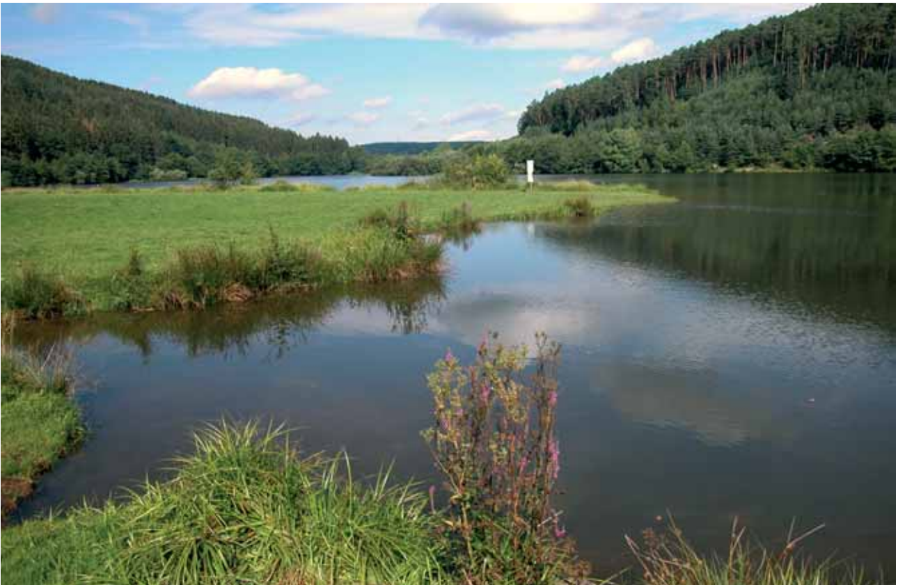
Abb. 10: Marbachtalsperre im Odenwald.
