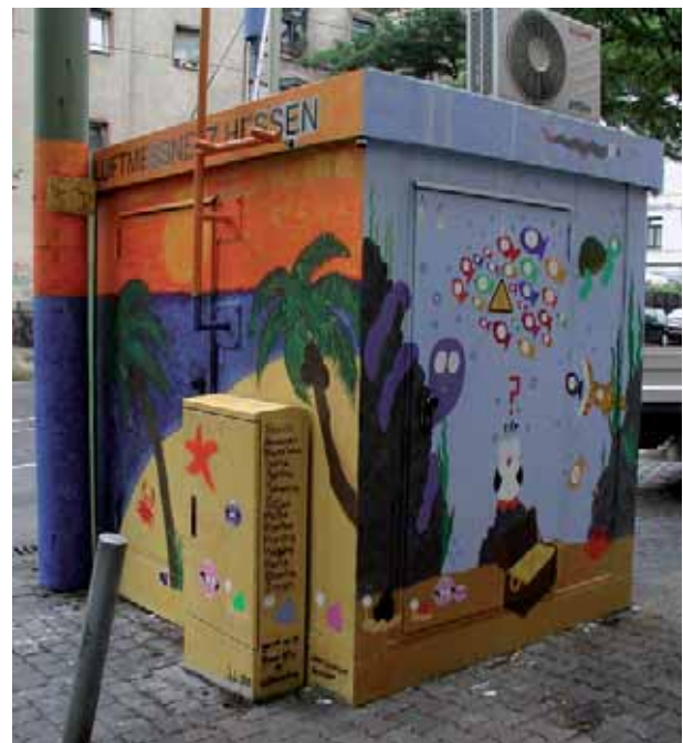
Luftmessstation „Frankfurt-Friedberger-Landstraße“, 2005 (nachher)
