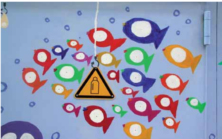
Detailansicht der Luftmessstation „Frankfurt-Friedberger-Landstraße“, 2005 (nachher)
