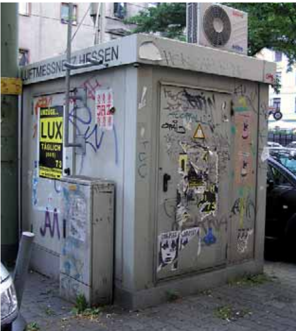
Luftmessstation „Frankfurt-Friedberger-Landstraße“, 2005 (vorher)
