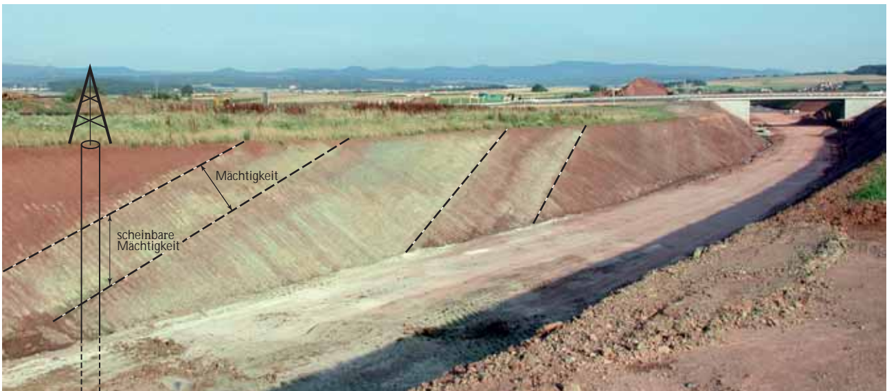
Abb. 6: Mit etwa 30 ° nach Nordosten einfallende Schichten des Oberen Buntsandsteins am Rand des Großenlüderer Grabens bei Fulda-Sickels (Bau der Westumgehung Fulda, August 2007; Aufschlusswand NNW–SSE orientiert). Eine Bohrung in solchen verkippeten Schichten ergibt stark erhöhte, sog. scheinbare Mächtigkeiten.
