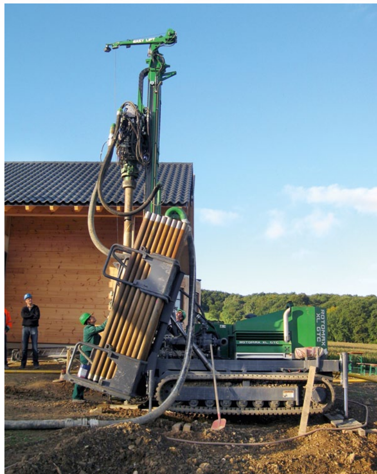
Abb. 1: Errichtung einer Erdwärmesondenanlage zur Nutzung der oberflächennahen Geothermie.
