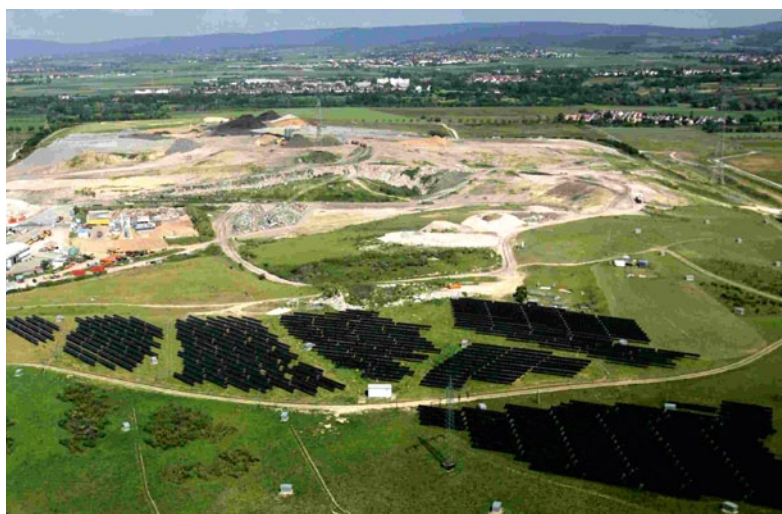
Abb. 2: Fotovoltaik-Freiflächenanlage auf dem Gelände des Deponiepark Flörsheim-Wicker. (Foto: Deponiepark Flörsheim-Wicker.)
