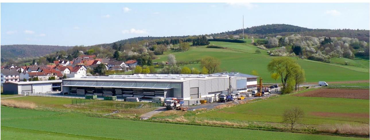
Abb. 1: Die neuen Produktionshallen in Heubach, die mit Erdwärme geheizt bzw. gekühlt werden sollen.
