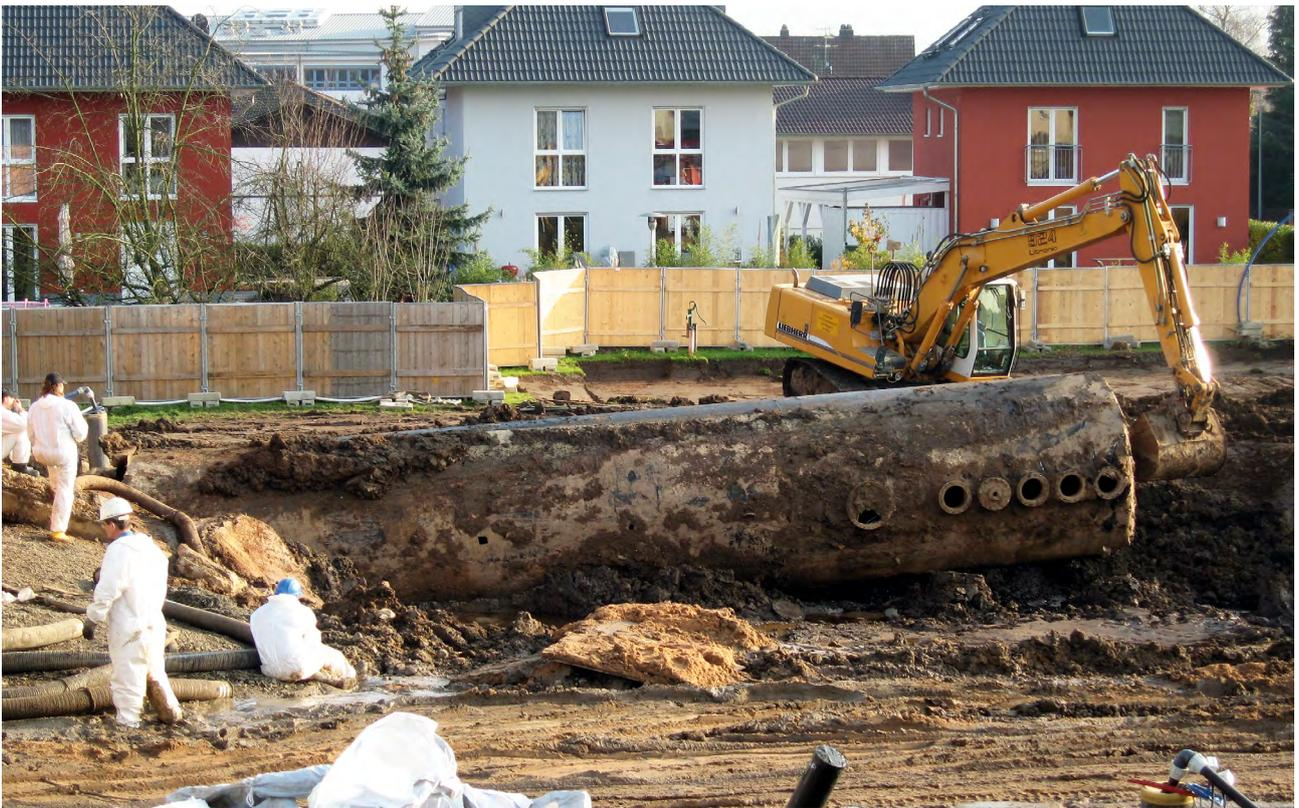
**Abb. 2:** Tankaushub und Bodensanierung © HIM-ASG
