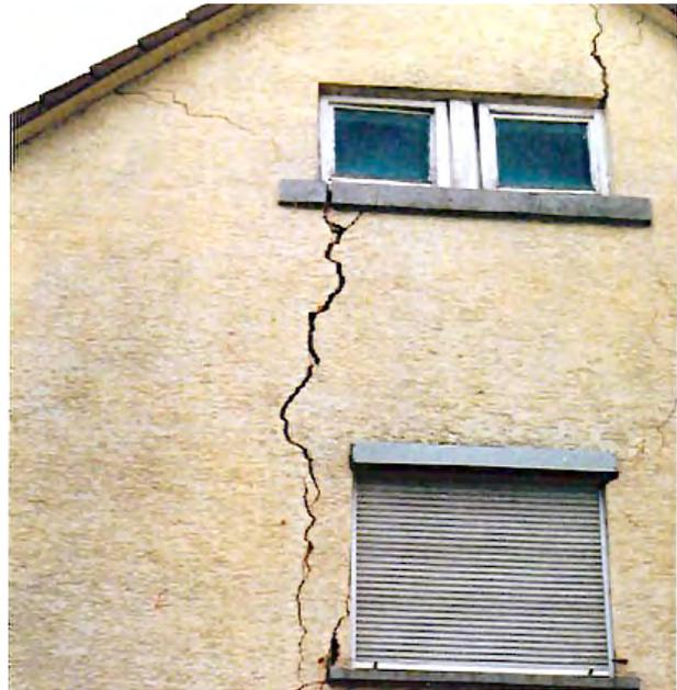
**Abb. 5:** Gebäudeschaden in Form von Rissen durch Setzungen des Untergrundes
