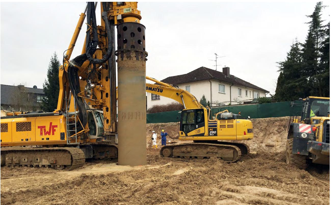
**Abb. 3:** Bodensanierung mittels Großlochbohrungen © HIM-ASG
