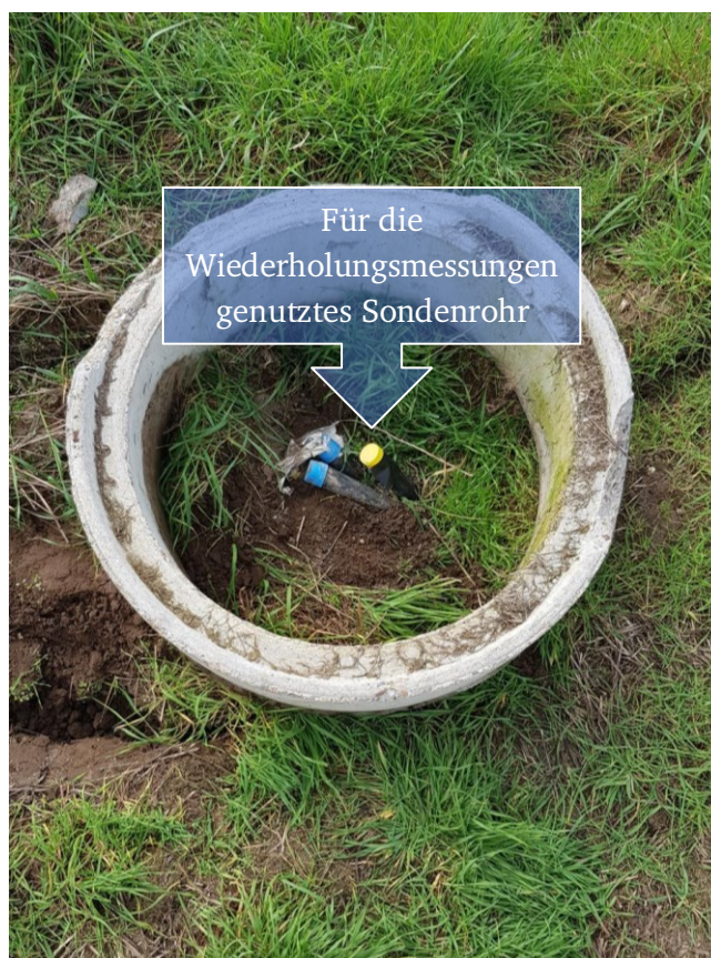
Abbildung 1: Situation untersuchten EWS mit Doppel-U. Sondenschenkel mit gelber Verschlusskappe wurde für die Wiederholungsmessung genutzt, eigene Aufnahme
