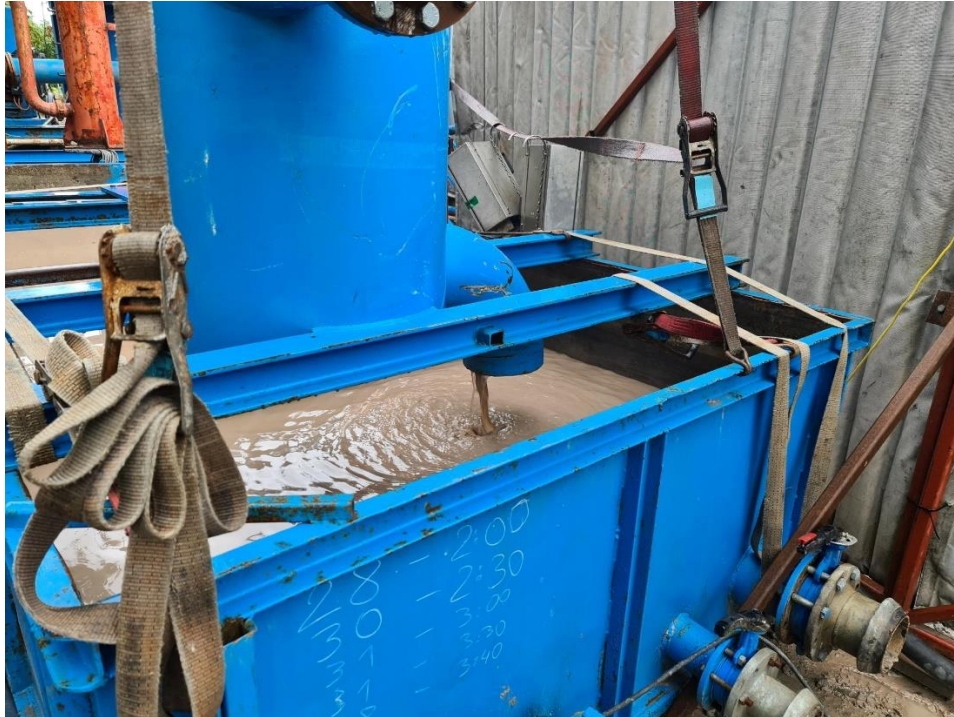
Abb. 19: Probenahmestelle am Ausfluss der Thermalsole (Airlift am 31.07.2023)
