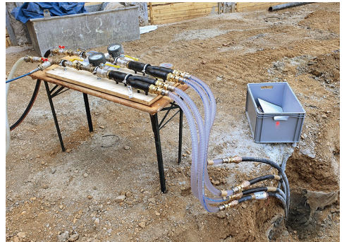
Abb. 5: Durchflussmessung an eingebaute Doppel-U-Erdwärmesonde (Foto: Fa. BauGrund Süd, Bad Wurzach)
