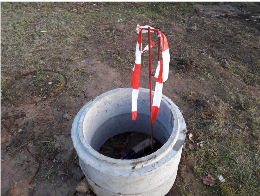
Abb. 3: Erdwärmesonde nach Ende der Testarbeiten
