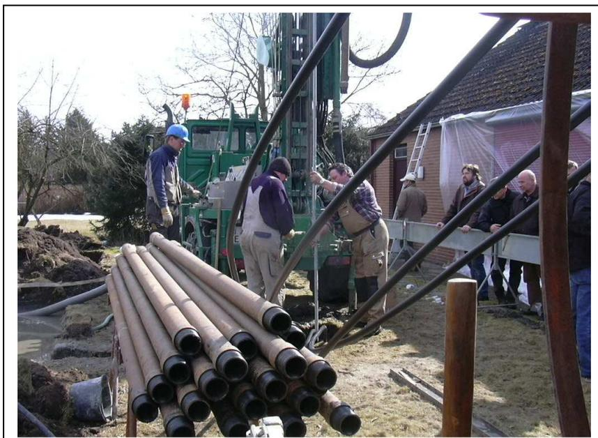
Abb. 4 Fachgerechter Einbau der Erdwärmesonden mit einem Verpressgestänge
