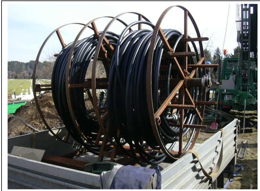
Abb. 3 Auf Haspeln aufgewickelte Sonden
