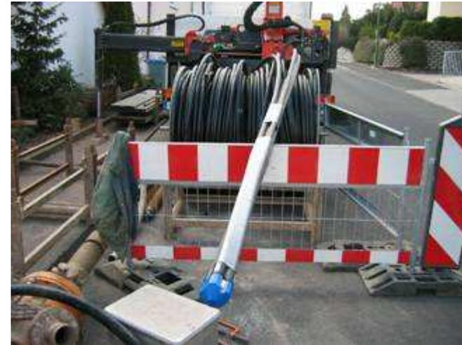
Sondenrohrdurchmesser:  25 mm  32 mm  40 mm
