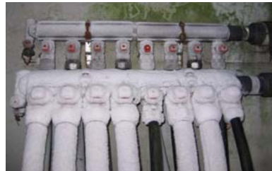
vereister Erdwärmesondenverteiler
