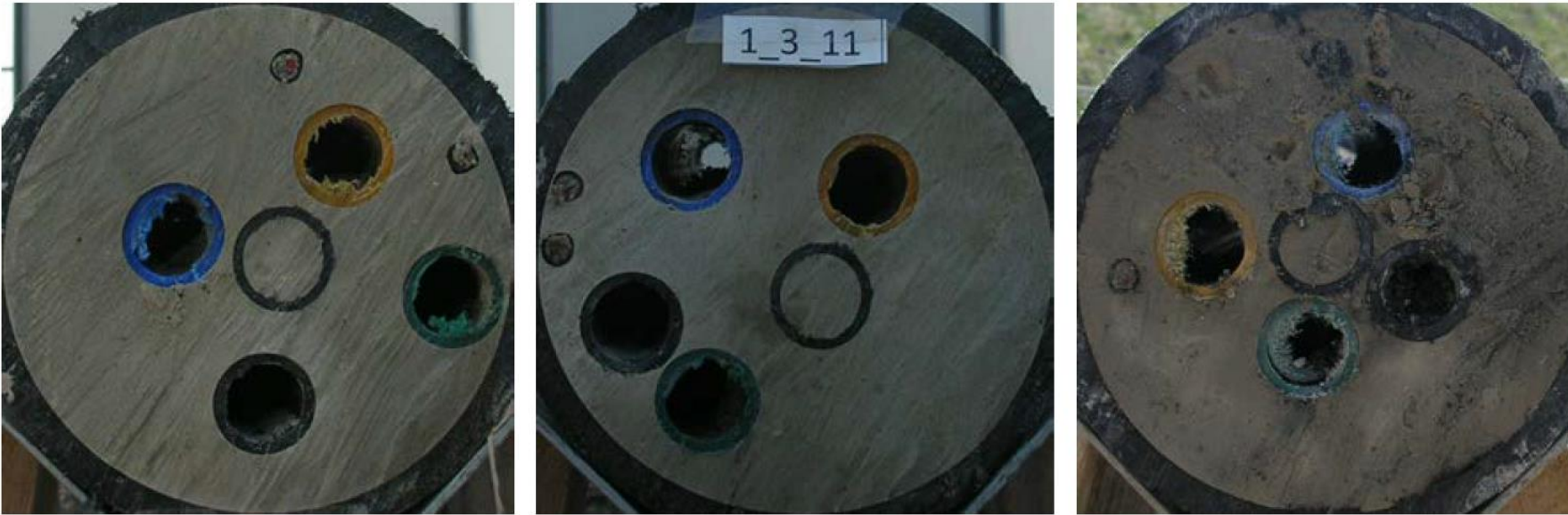
Abbildung 5-1: Querschnittsbilder der EWS 1-3 mit Abstandshaltern (links und Mitte) und Querschnittsbild der EWS 2-3 mit Zentrierhilfen (rechts) in einem Tiefenbereich, in dem die Abstandshalter bzw. Zentrierhilfen im Abstand von 1 m eingebaut waren
