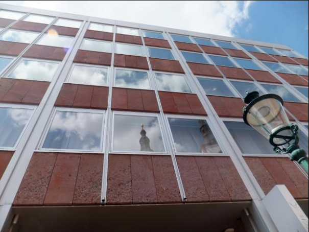
Fassadenplatten aus Michelnauer Schlackenagglomerat am Hotel „Platzhirsch“ in Fulda.
