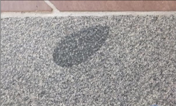
Bodenplatte im Fuldaer Dom aus dioritischen Gestein, wie es z.B. im kristallinen Odenwald und Spessart vorkommt.
